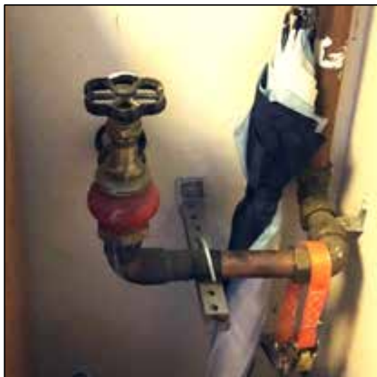
V2 Brandvatten till skåp på utsidan
