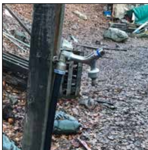
V24. Kran mellan presenningsboden och slipspelet
