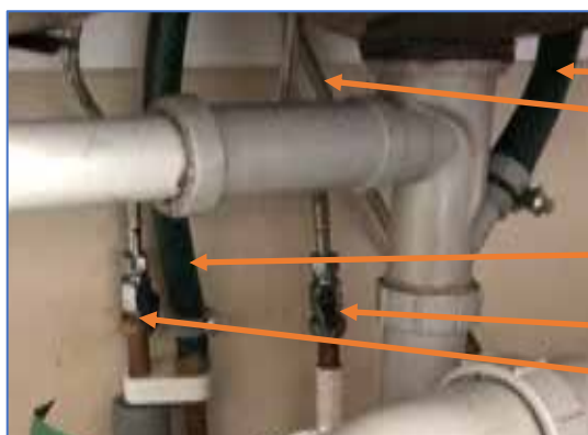
Installation under diskbänken.
