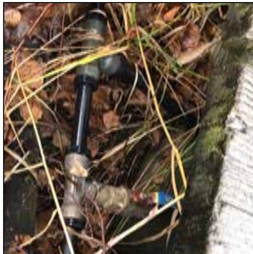
V18. Avtappning och förgrening till motorboden
