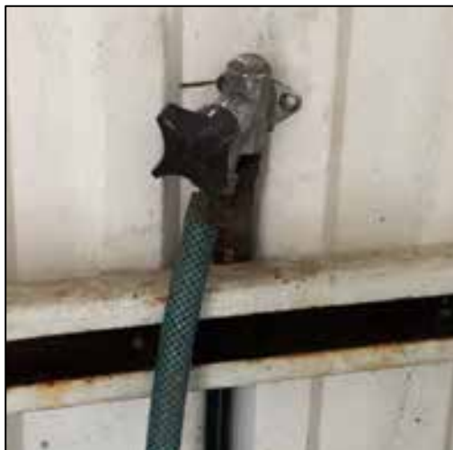
V17. Kran vid rännan på herrarnas.
