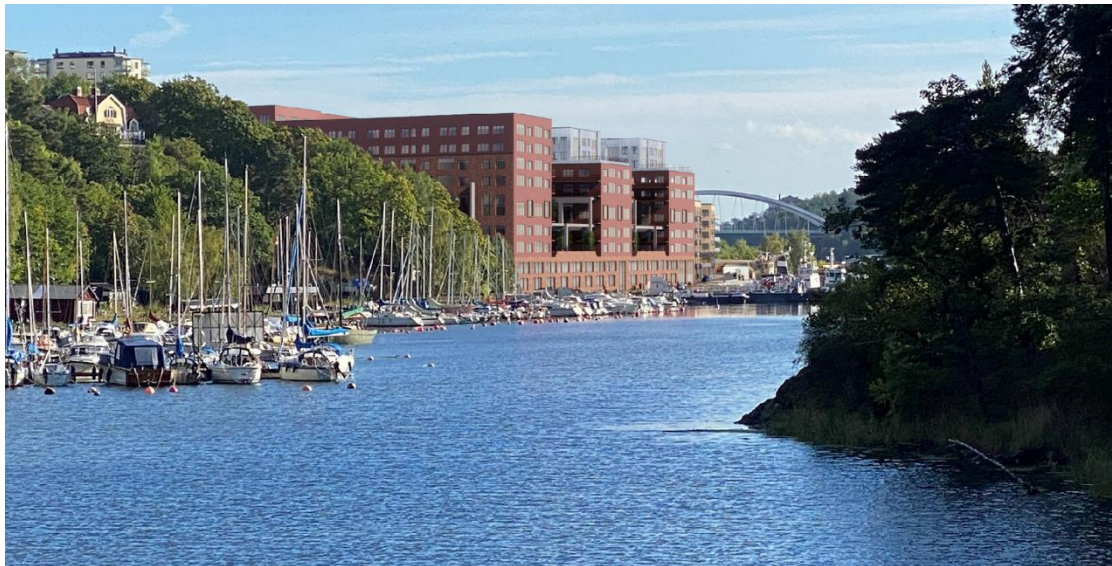
Vy som visar Kafferosteriet ombyggt till bostäder sett västerifrån. Bild: Gatun Arkitekter
